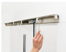
4. Montaje de soporte del embellecedor con la misma llave Allen
