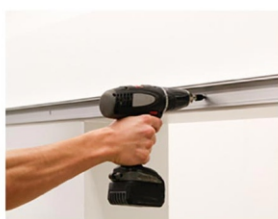
1. Montaje del carril de rodadura desde la parte delantera
