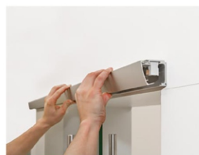
5. Pinzado del perfil embellecedor
