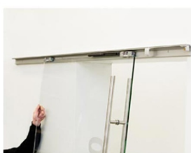
3. Enganche de la hoja de la puerta en la guía corredera delantera
